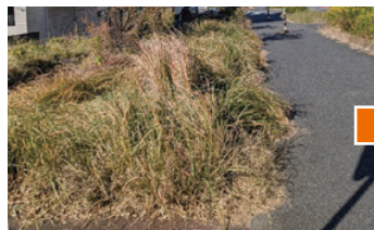
雑草が覆い茂った上戸田一目17号線沿いの歩道
